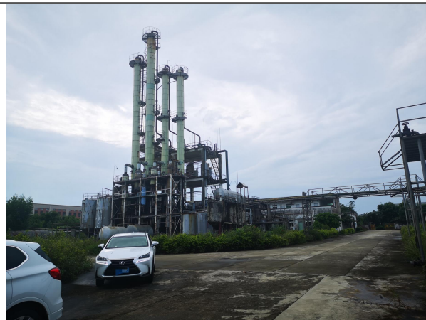
项目西北侧：废弃工厂
