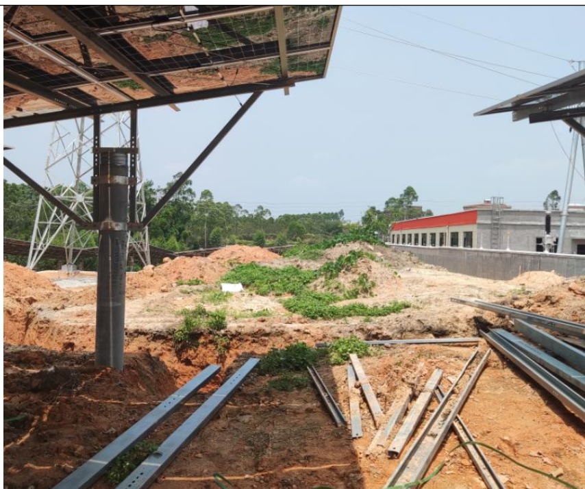
长山光伏 110kV 升压站及周边杂草地
