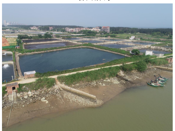
管网穿越处塘尾分洪河东岸
