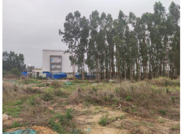
北侧（杂草地、桉树林、乾塘变电站）
